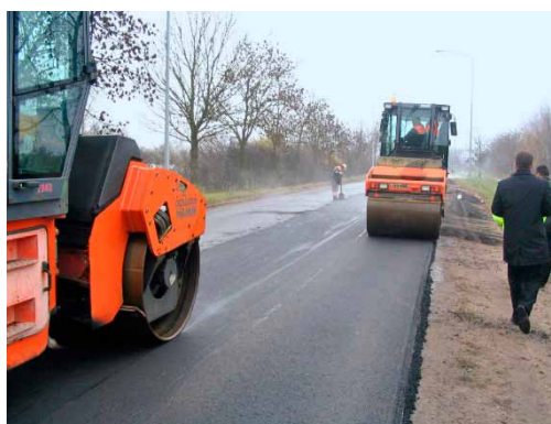
4 pav. Asfalto dangos įrengimas iš šiltojo asfalto mišinio kelyje Nr. 153 Joniškis–Žagarė
