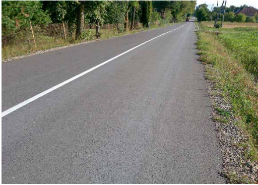
6 pav. Dangos paviršiaus vaizdas po dvejų jos eksploatacijos metų bandomajame ruože (kelyje Nr. 153 Joniškis–Žagarė)
