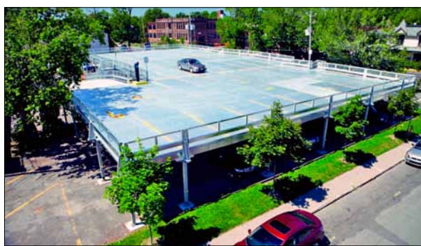
4 pav. Modulinė automobilių stovėjimo aikštelė: a – modulinės automobilių stovėjimo aikštelės schema, b – Kanadoje įrengtos modulinės automobilių stovėjimo aikštelės nuotrauka (American Galvanizers Association 2014)
