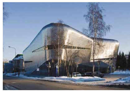
21 pav. Šachmatų klubo Chanty Mansijske eksterjeras, Rusija, archit. E. van Egeraat, 2010 m.
