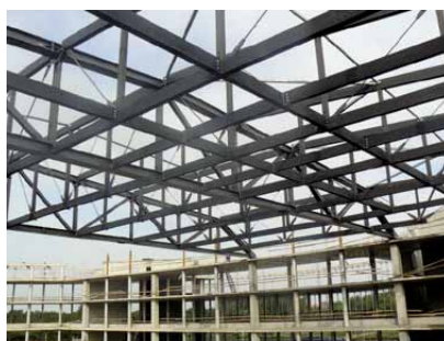
39 pav. Medžio ir metalo konstrukcijų perdenginys Šiaulių sporto arenoje, archit. biuras „E. Miliūno studija“, 2007 m.
