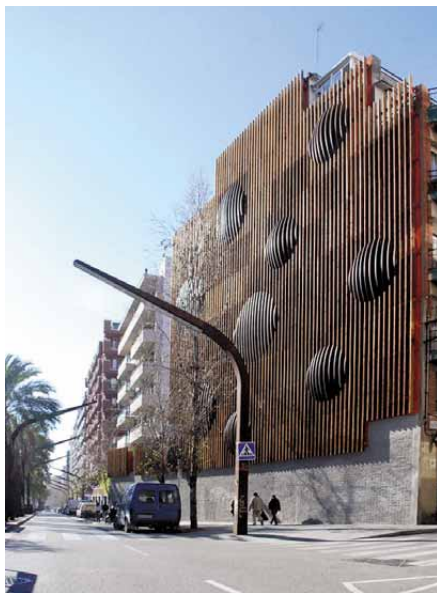
42 pav. Pastato sienos renovacija sukuriant naują medinį fasadą (projektas), Barselona, Ispanija, archit. D. B. Salva, 2008 m.
